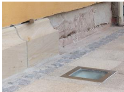
Schäden durch Witterung und Verkehr
